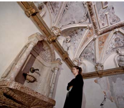
Vom Deckengemälde im Musensaal sind heute nur noch Fragmente erhalten. Darunter ziert ein Wasserbecken aus Rotmarmor an der Nordwand den größeren der beiden Räume in den Badstuben.
