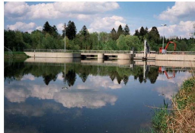
Stützschwellenkraftwerk Großaitingen von Oberwasser, circa 30 Jahre nach Fertigstellung
