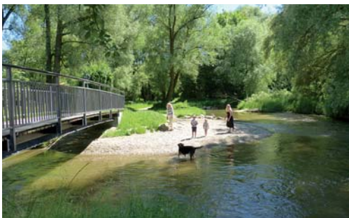
Eine Fußgängerbrücke überspannt den Fluss beim Paardurchbruch am Ortsrand von Ottmaring, einem ländlichen Stadtteil des nahen Friedberg.
